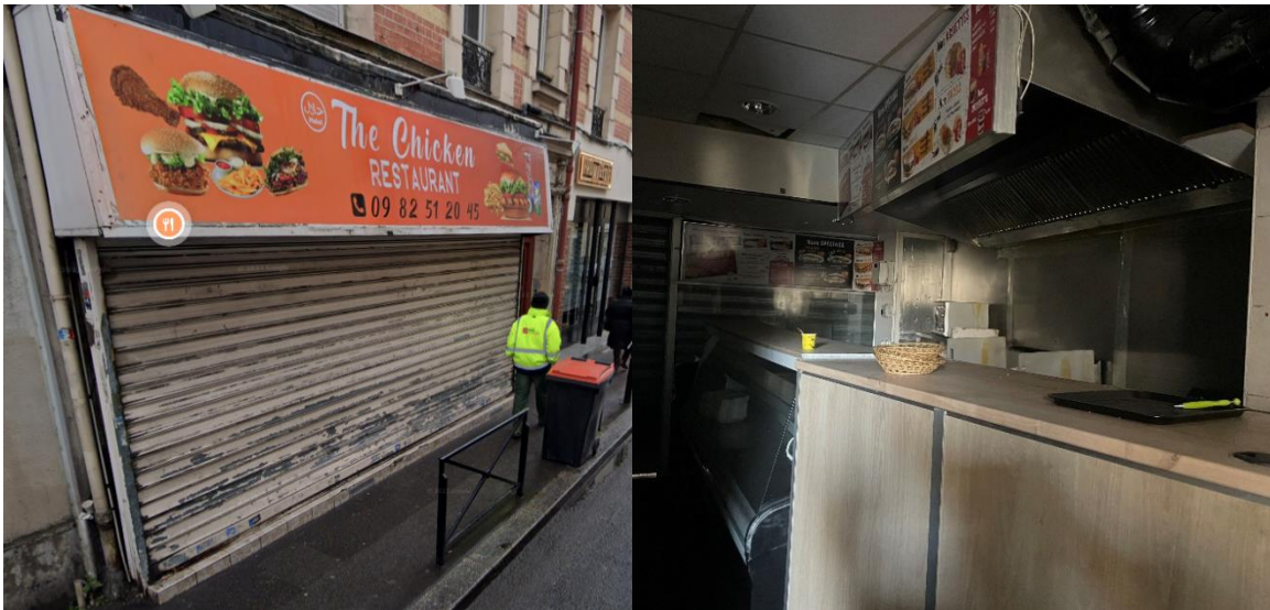
Photos du 13 rue Charron avant travaux
