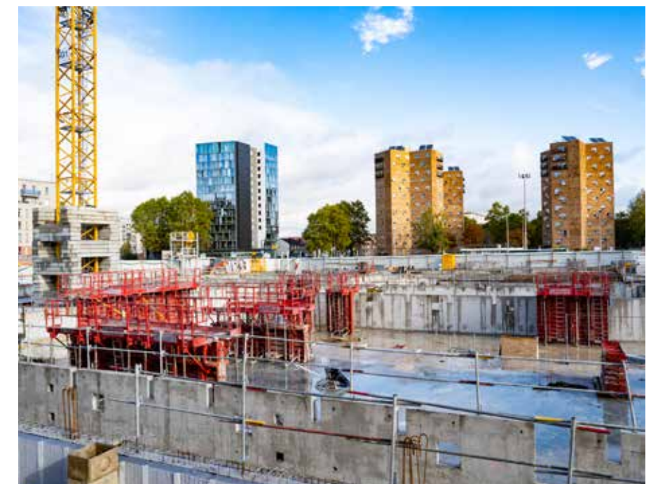
Chantier du nouvel éco-quartier du Fort d'Aubervilliers. © Michael Barriera
